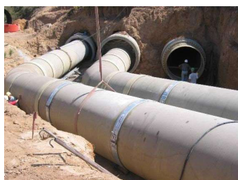
Рисунок 4-15 Гибкая стальная муфта
