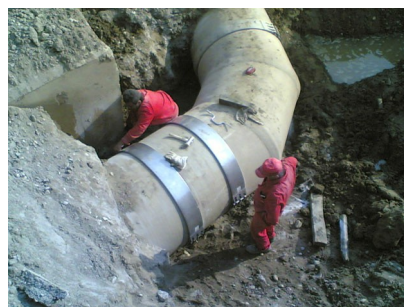
Рисунок 4-15 Гибкая стальная муфта
