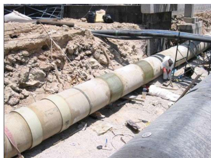
Рисунок 4-14 Соединение с помощью ламинации
